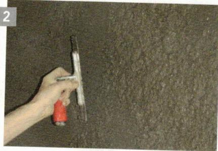
2 Nach dem Aufspritzen wird der frische Putz grob abgeglättet. Partiiell soll die Spritzstruktur stehen bleiben.
