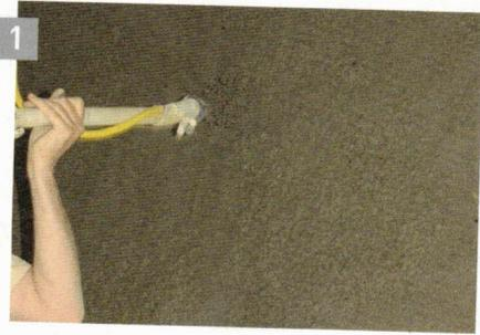
1 Auf die erste vollflächige Lage Lehmputz wird nach dem Trocknen eine zweite Lage partiell aufgespritzt.
