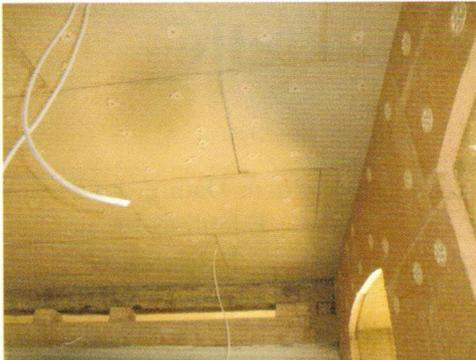
An die Decken werden Lehm-Platten geschraubt und an die Wände Holz-Platten geklebt und geschraubt.
